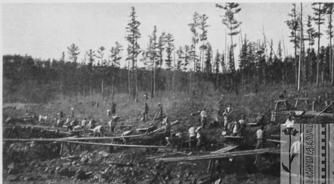
№ 17. Каторжные на работѣ по постройкѣ Амурской ж. д.
